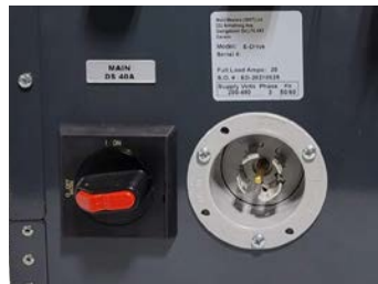
Figure 10-1 Trennschalter und Netzanschluss
